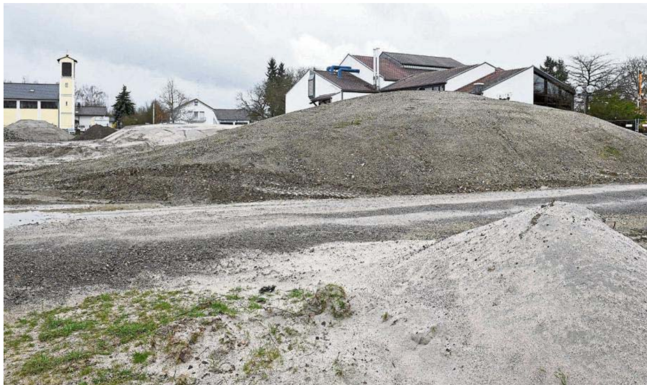
AUSHUB UND MATERIAL vom und für den Neubau des Hallenbads in Blankenloch lagern derzeit auf dem ehemaligen Neise-Gewerbeareal. Mit der Fläche des alten Bads zusammen soll dort generationenübergreifendes Wohnen entstehen. Foto: Hora
